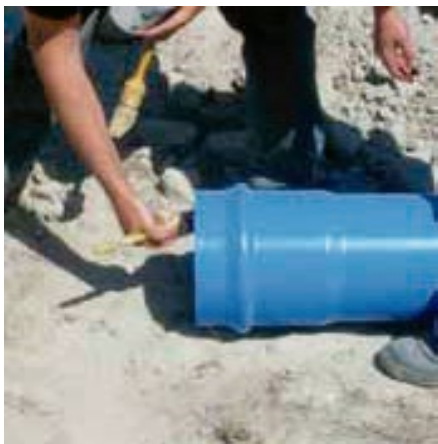
Aplicar lubricante en el bisel del cabo y en la junta de la embocadura.
