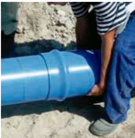
Alinear la tubería e introducir el bisel en la entrada de la copa.
