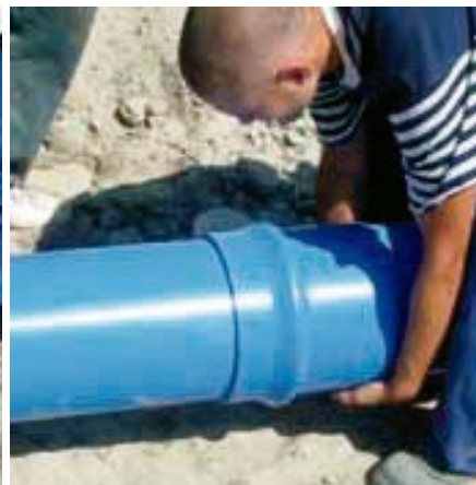
Dar un empujón firme y seco con el tubo cuyo cabo se va a introducir en la copa para de esta forma aprovechar la inercia del tubo. Introducir el cabo hasta que se oculte la marca.
